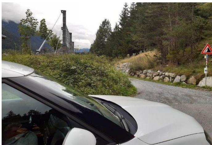
Bei der Einfahrt ins Doarni über die Straße beim Feuerwehrhaus gibt es eine sehr unübersichtliche Stelle. Der Damm für den Steinschlagschutz nimmt besonders beim Abbiegen nach links nahezu jede Sicht. Eine leichte, keilförmige Abgrabung von mehreren Metern Länge auf der nördlichen Wegseite würde den Steinschlagschutz nicht mindern, aber für die frühere Erkennung von Fußgängern und Verkehrsteilnehmern (besonders Radfahrer) sehr hilfreich sein.
